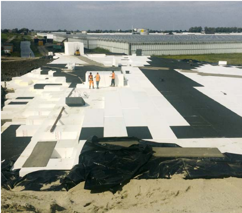
Figuur 1 – Lichtgewicht wegophoging (in de noordelijke richting) van de ontsluitingsweg en de rotonde van de N222.
