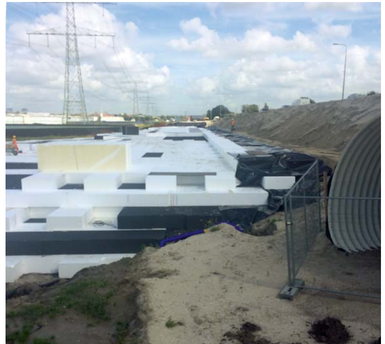
Figuur 2 – Lichtgewicht wegophoging (in de oostelijke richting) van de rotonde en de wegverbreding van de N222.
